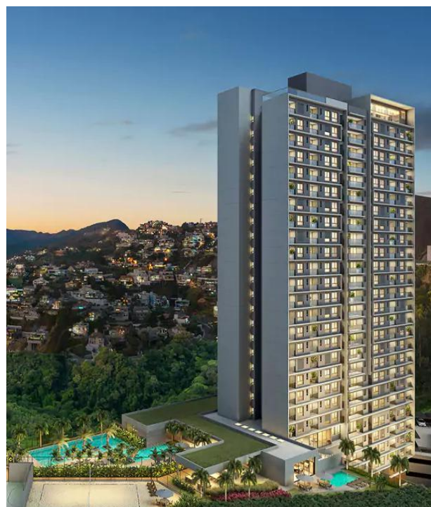
Patrimar | Madison Square, Nova Lima/ MG Lançamento: 4T25
