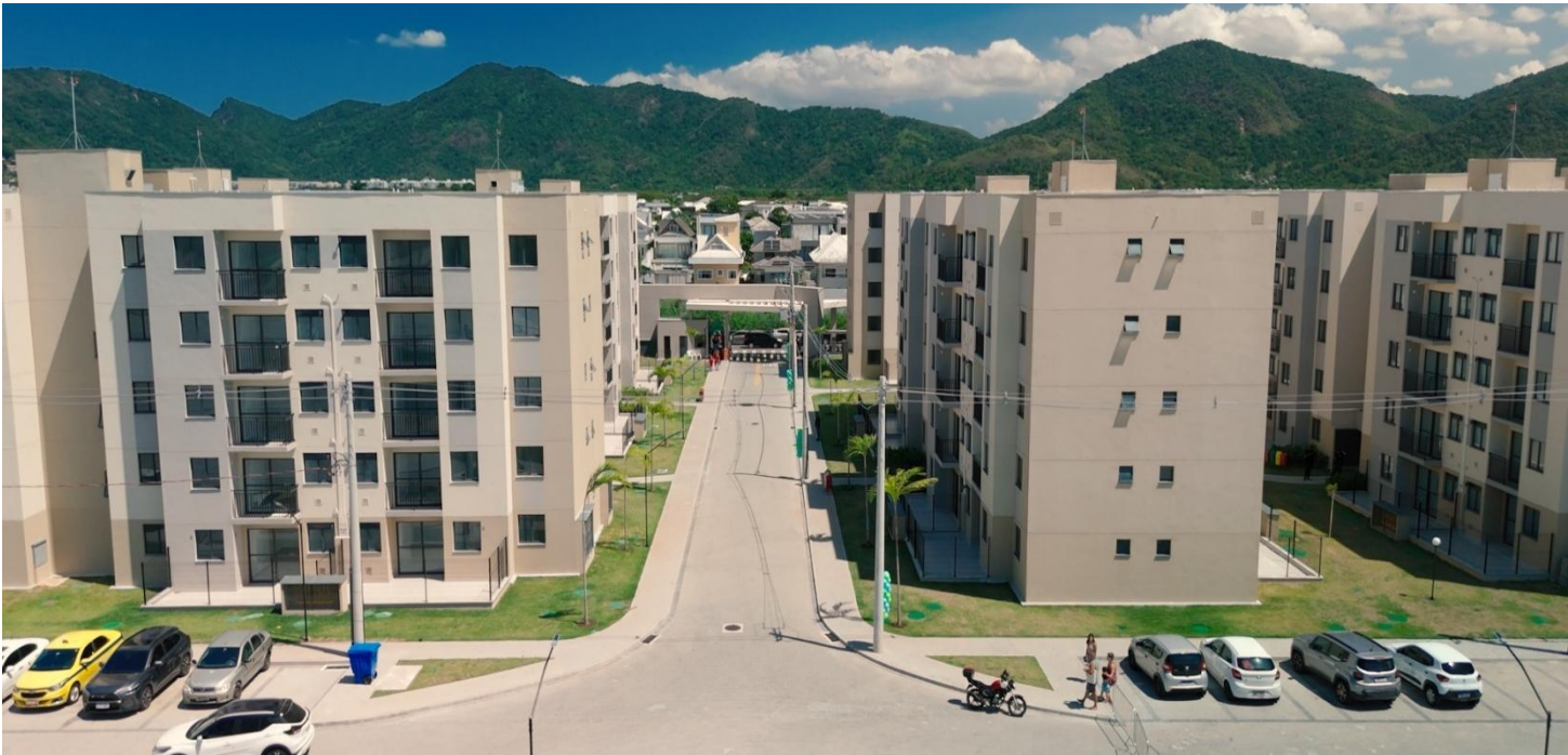
Novolar | Recreio – Rio de Janeiro/RJ Delivered 1Q25
